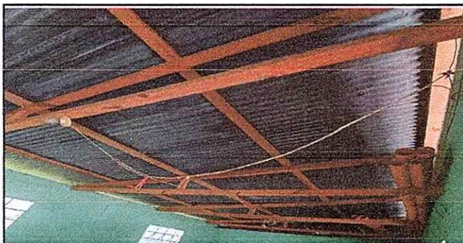
FOTO 5: ESTRUCTURA DE MADERA MUY DETERIORADA
